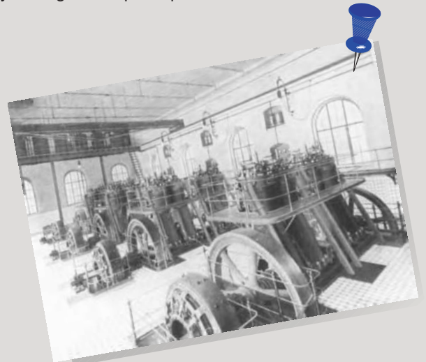
Ruang mesin Alexandrowskaja di kota Kiev dengan empat mesin generator MAN Augsburg 4-tak, di tahun 1904
